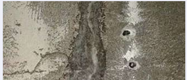
PU injection in a canal
